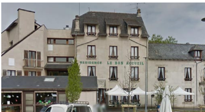
EHPAD actuel, source : Google street view
